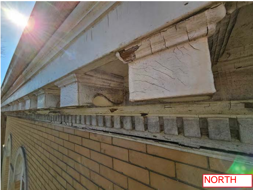
2023-03-29_Existing Cornice & Exterior_63.jpg
