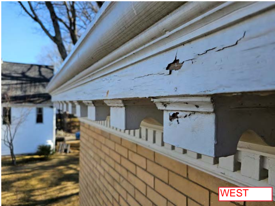
2023-03-29_Existing Cornice & Exterior_39.jpg
