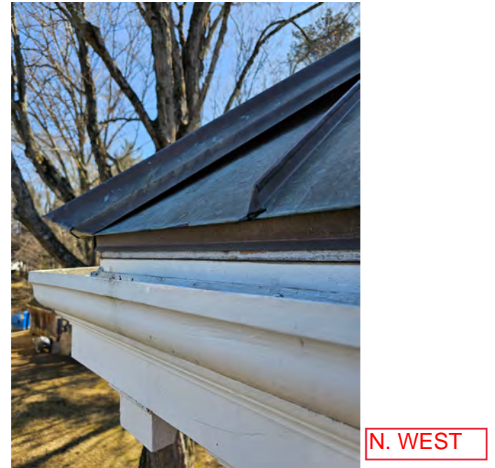
2023-03-29_Existing Cornice & Exterior_56.jpg
