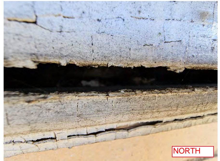
2023-03-29_Existing Cornice & Exterior_60.jpg
