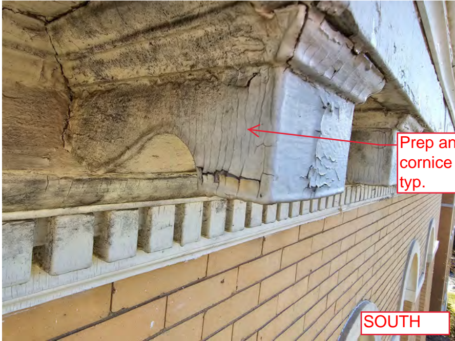
2023-03-29_Existing Cornice & Exterior_25.jpg
