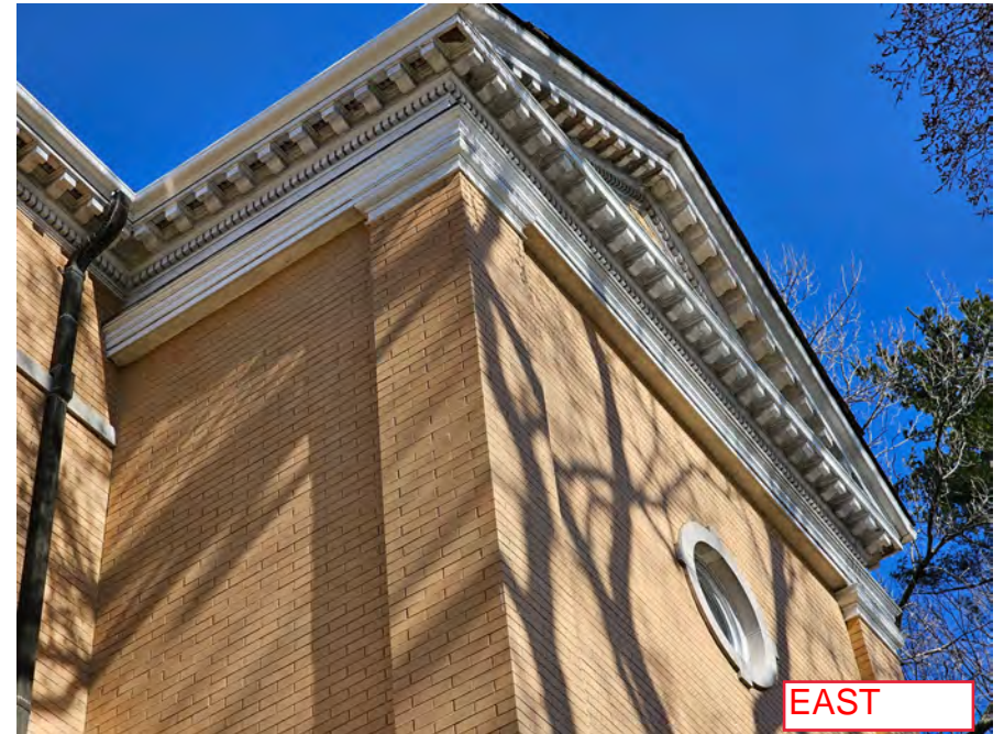
2023-03-29_Existing Cornice & Exterior_95.jpg
