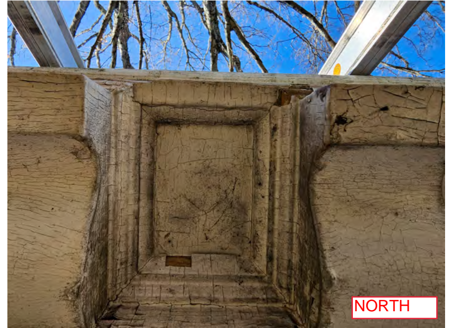
2023-03-29_Existing Cornice & Exterior_73.jpg
