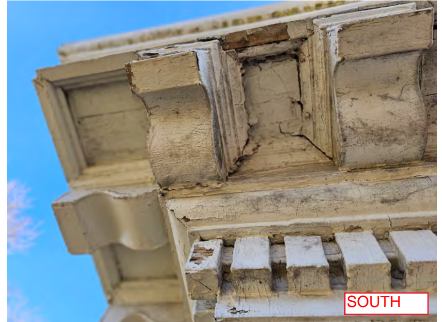
2023-03-29_Existing Cornice & Exterior_31.jpg
