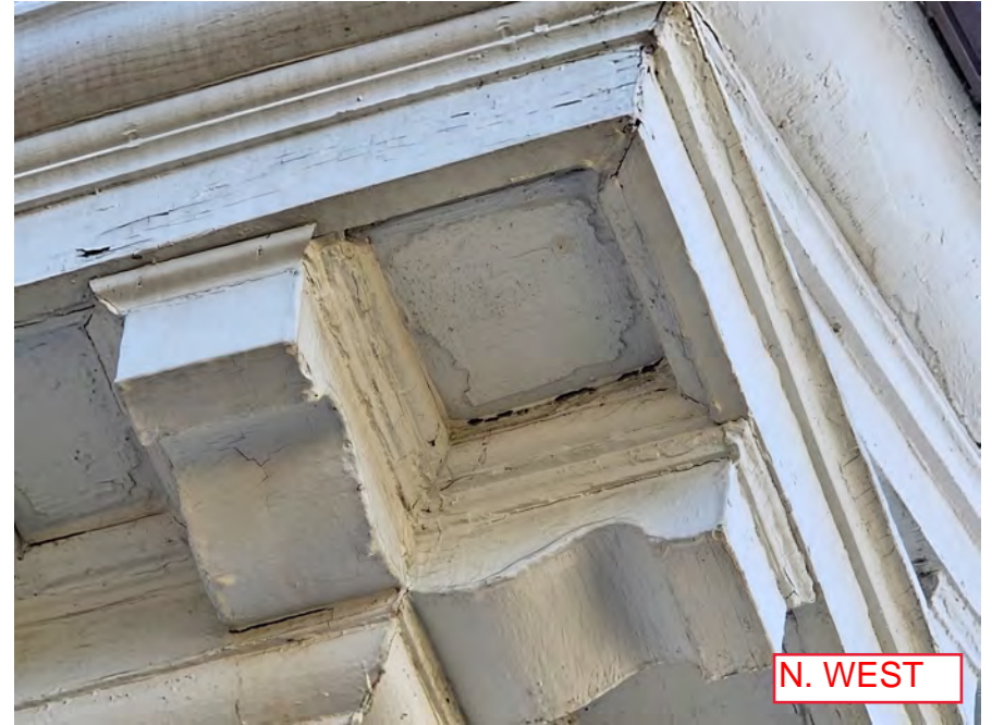
2023-03-29_Existing Cornice & Exterior_50.jpg
