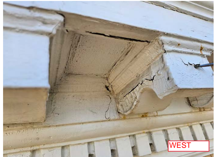
2023-03-29_Existing Cornice & Exterior_52.jpg
