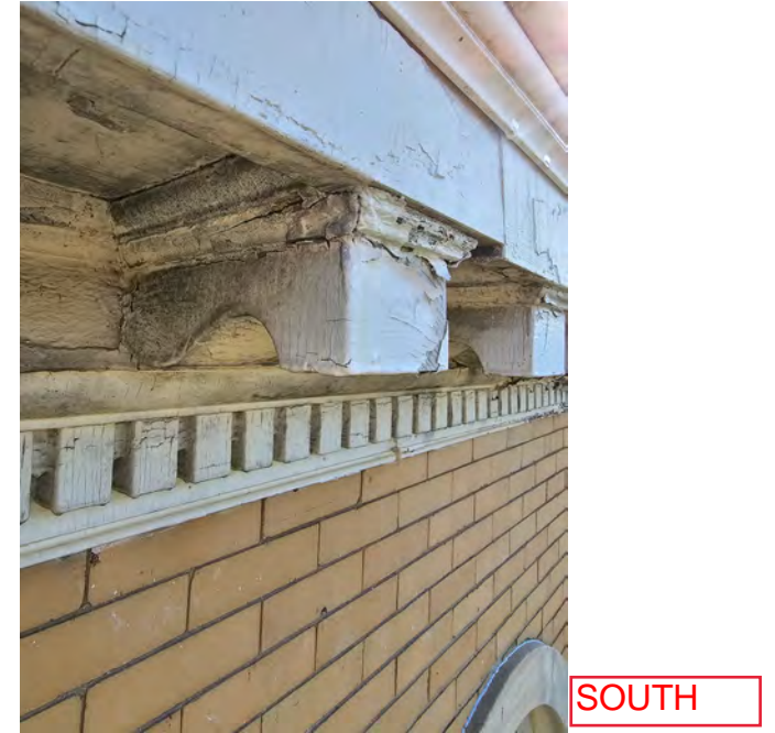
2023-03-29_Existing Cornice & Exterior_26.jpg
