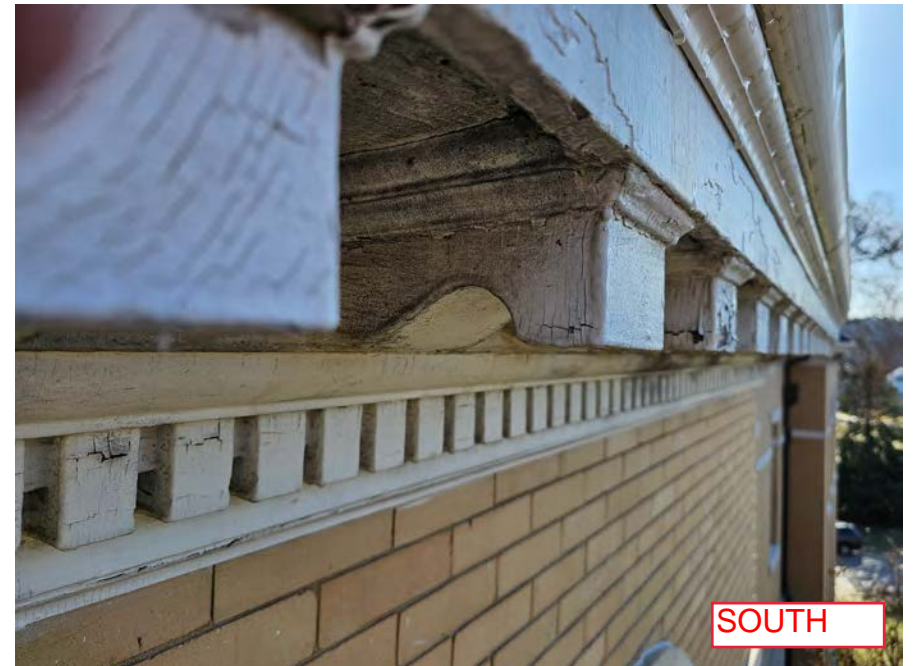
2023-03-29_Existing Cornice & Exterior_05.jpg
