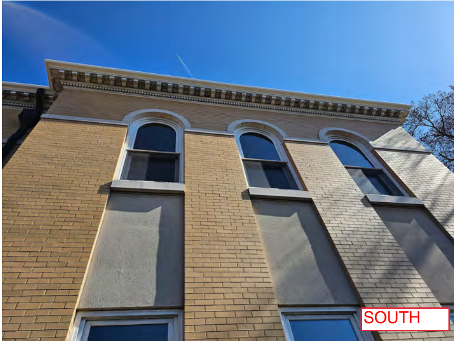
2023-03-29_Existing Cornice & Exterior_90.jpg
