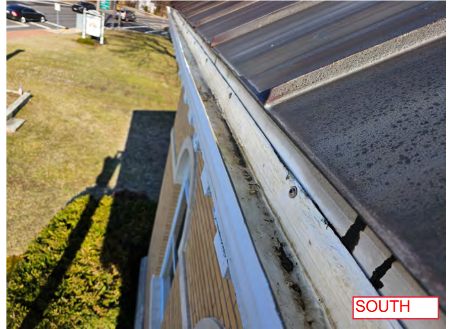
2023-03-29_Existing Cornice & Exterior_07.jpg
