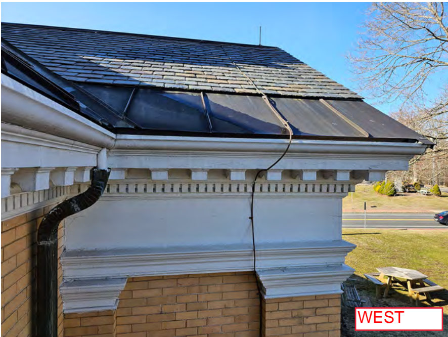
2023-03-29_Existing Cornice & Exterior_43.jpg
