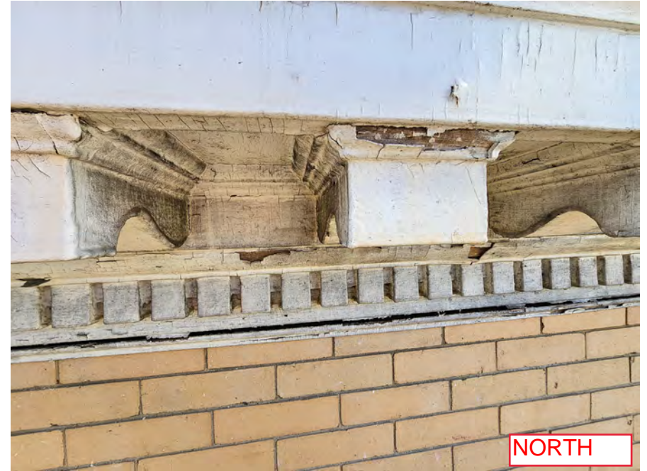
2023-03-29_Existing Cornice & Exterior_62.jpg
