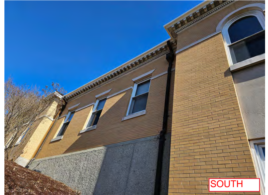
2023-03-29_Existing Cornice & Exterior_91.jpg
