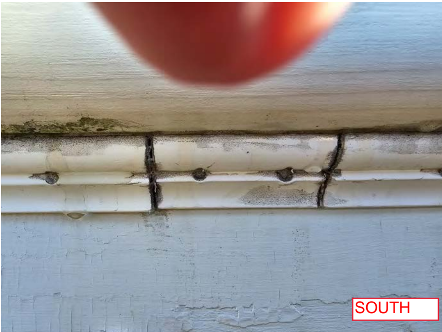
2023-03-29_Existing Cornice & Exterior_08.jpg
