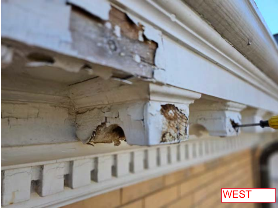
2023-03-29_Existing Cornice & Exterior_35.jpg
