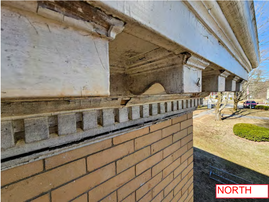
2023-03-29_Existing Cornice & Exterior_61.jpg
