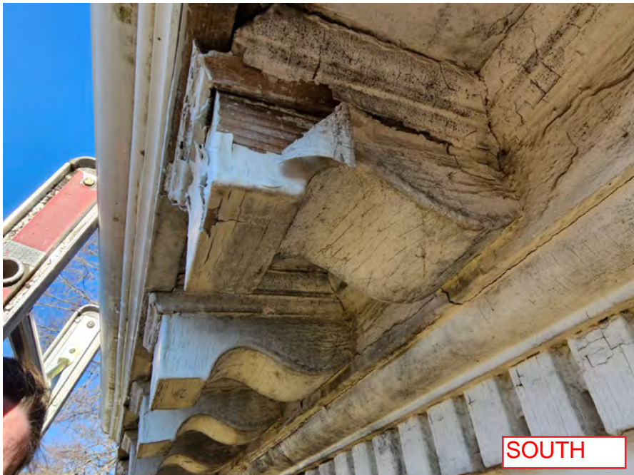
2023-03-29_Existing Cornice & Exterior_27.jpg
