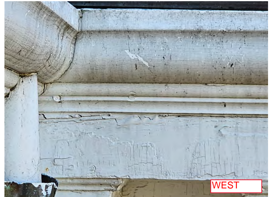
2023-03-29_Existing Cornice & Exterior_44.jpg
