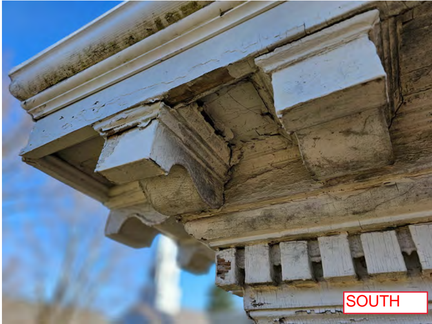
2023-03-29_Existing Cornice & Exterior_29.jpg
