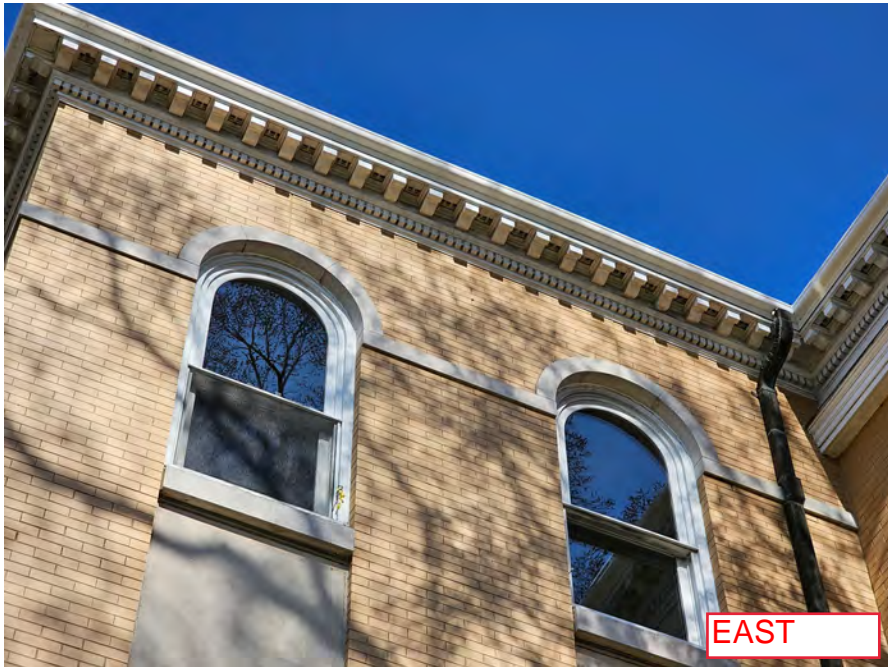
2023-03-29_Existing Cornice & Exterior_94.jpg
