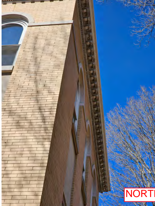
2023-03-29_Existing Cornice & Exterior_00.jpg
