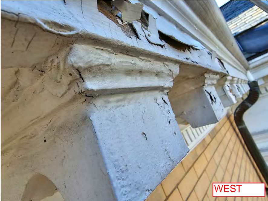
2023-03-29_Existing Cornice & Exterior_41.jpg
