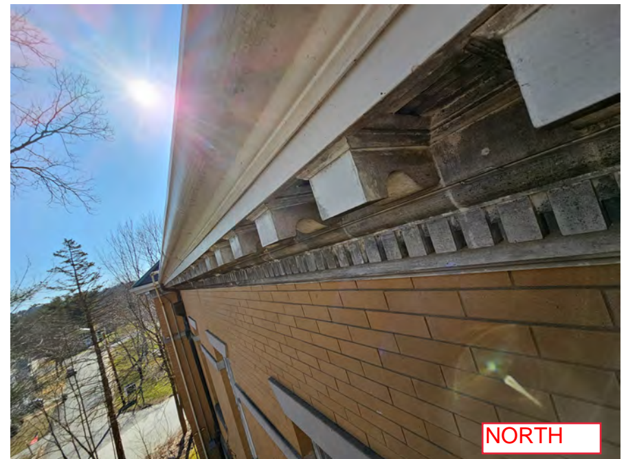
2023-03-29_Existing Cornice & Exterior_79.jpg
