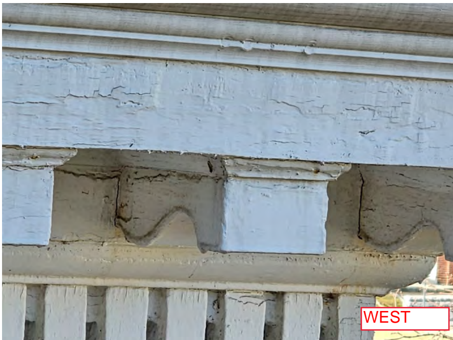
2023-03-29_Existing Cornice & Exterior_47.jpg
