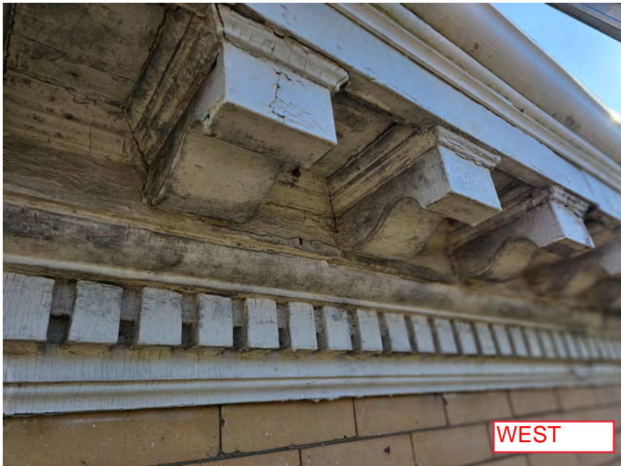
2023-03-29_Existing Cornice & Exterior_33.jpg
