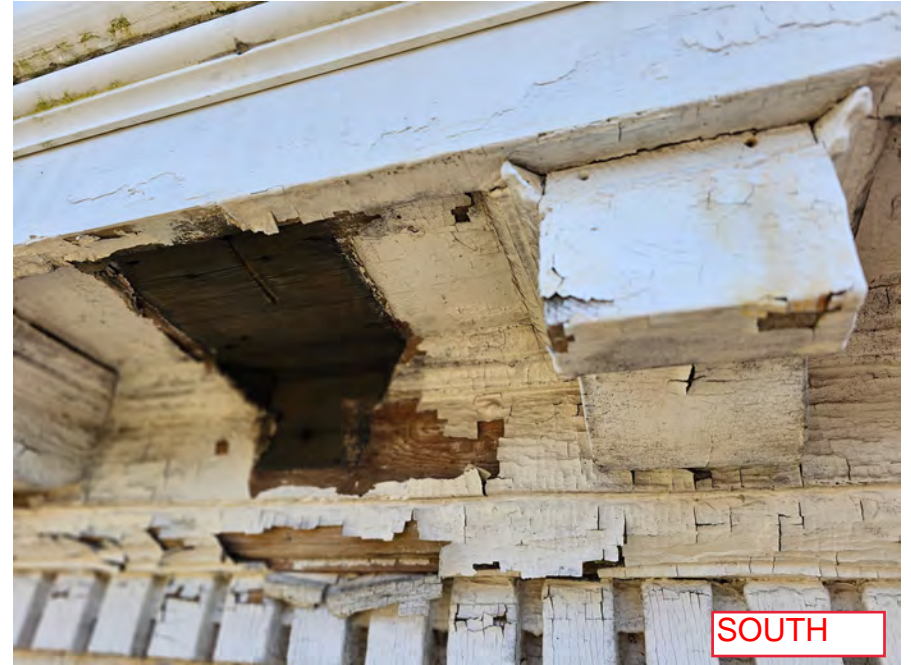
2023-03-29_Existing Cornice & Exterior_16.jpg
