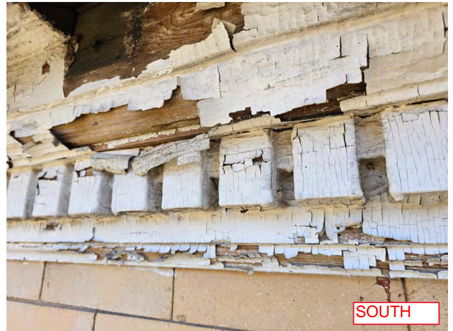
2023-03-29_Existing Cornice & Exterior_18.jpg
