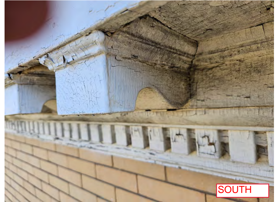
2023-03-29_Existing Cornice & Exterior_03.jpg
