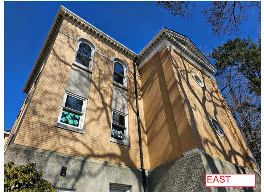
2023-03-29_Existing Cornice & Exterior_93.jpg
