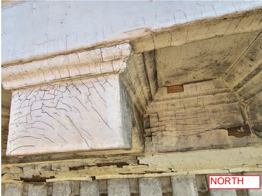
2023-03-29_Existing Cornice & Exterior_72.jpg
