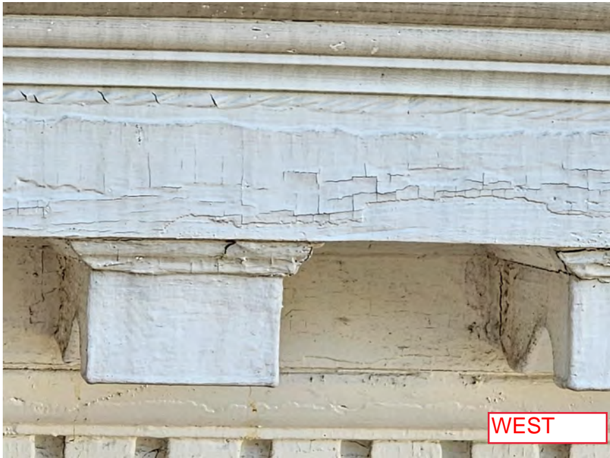
2023-03-29_Existing Cornice & Exterior_45.jpg
