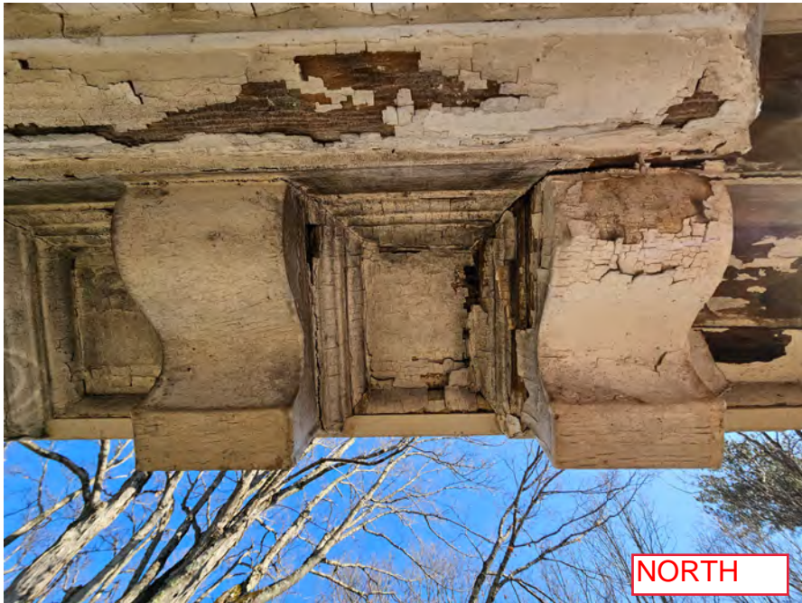
2023-03-29_Existing Cornice & Exterior_76.jpg
