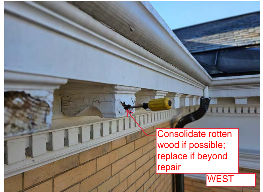
2023-03-29_Existing Cornice & Exterior_34.jpg
