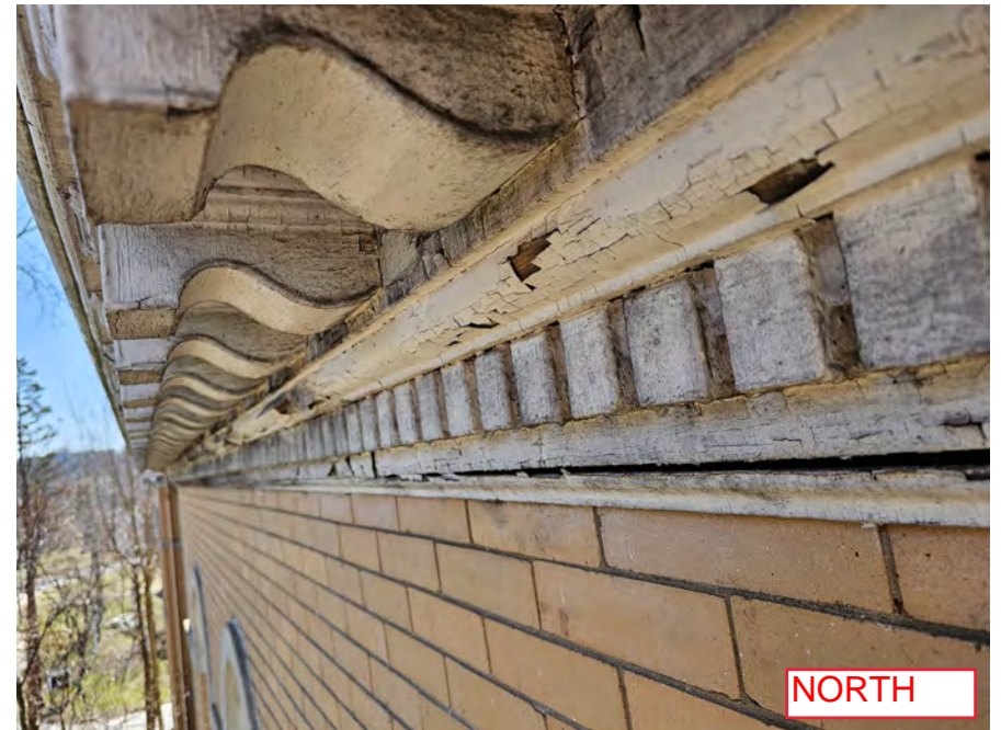
2023-03-29_Existing Cornice & Exterior_65.jpg
