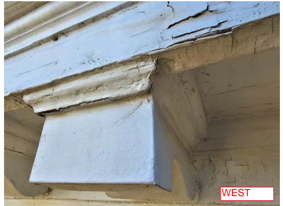
2023-03-29_Existing Cornice & Exterior_40.jpg
