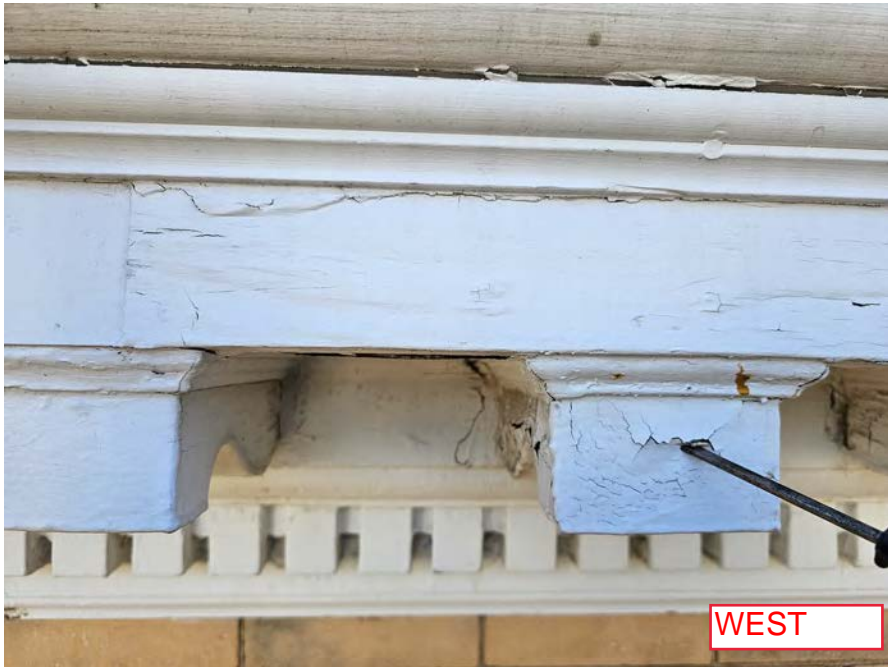
2023-03-29_Existing Cornice & Exterior_53.jpg
