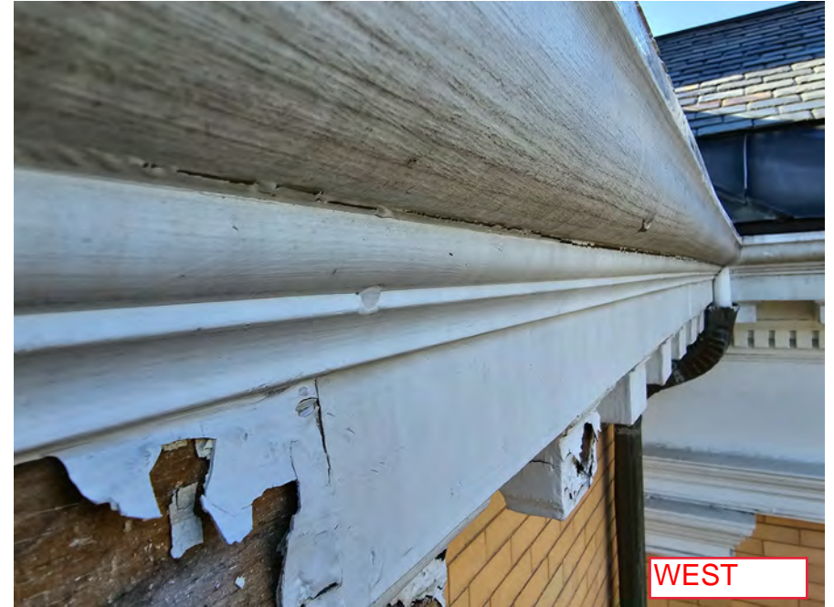
2023-03-29_Existing Cornice & Exterior_42.jpg
