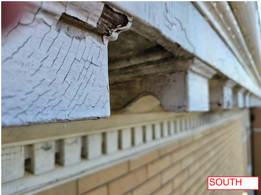
2023-03-29_Existing Cornice & Exterior_04.jpg
