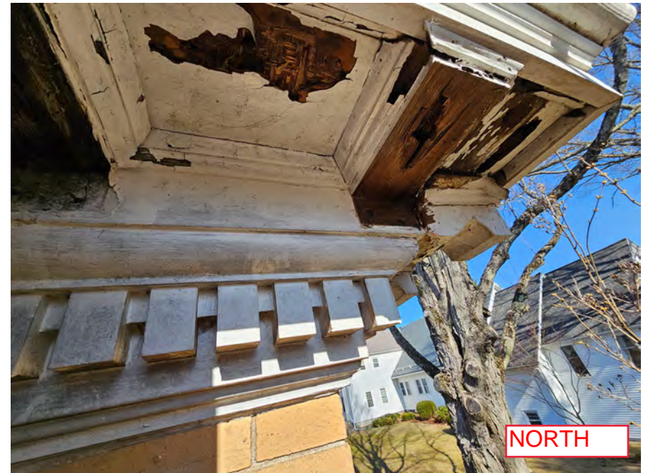
2023-03-29_Existing Cornice & Exterior_75.jpg
