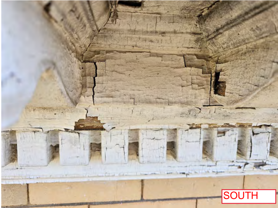
2023-03-29_Existing Cornice & Exterior_15.jpg
