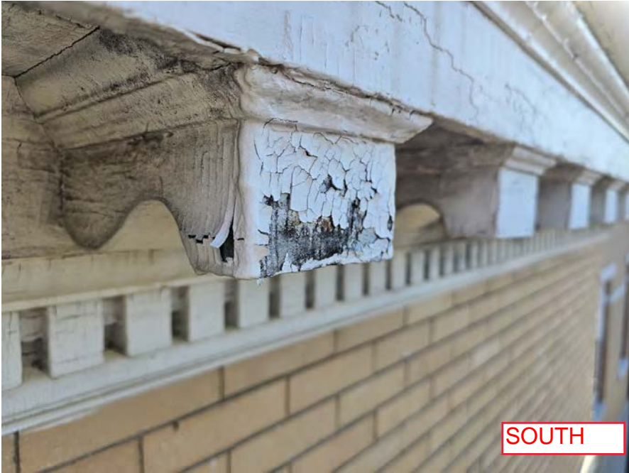
2023-03-29_Existing Cornice & Exterior_06.jpg
