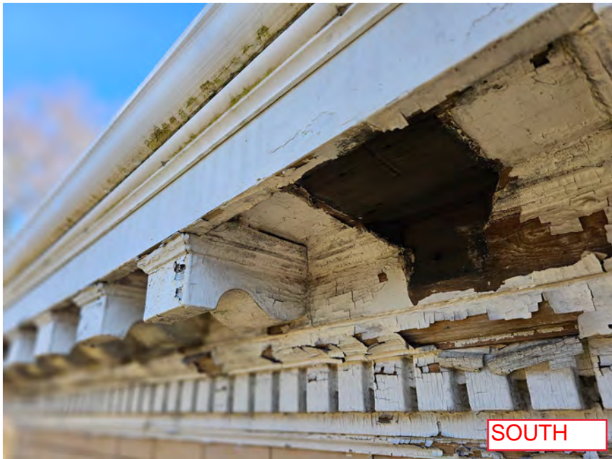
2023-03-29_Existing Cornice & Exterior_17.jpg
